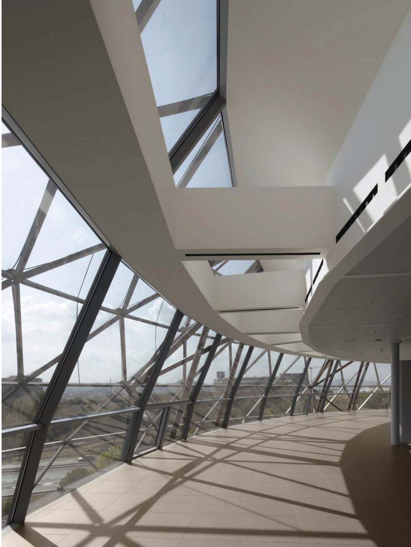
Il Cielo, Barcellona, Spain. Project: Josep Miàs - Miàs Arquitectes SistemT Graniti Grigio Scuro
